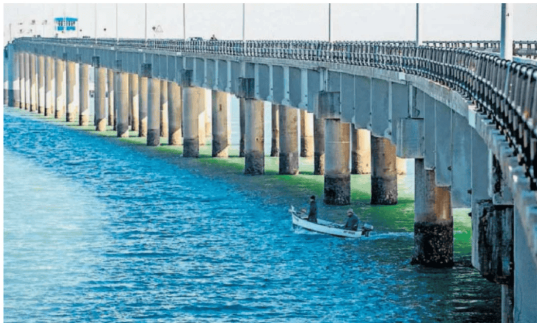
El puente de Cádiz José León de Carranza, en el punto kilométrico 3 de la carretera CA-36. JUAN CARLOS TORO
